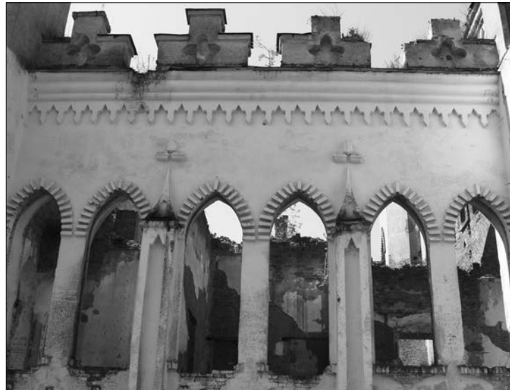
Na zdjęciu: Galeria łącząca korpus główny ze skrzydłem bocznym
