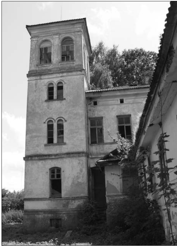
Na zdjęciu: Czterokondygnacyjna wieża
