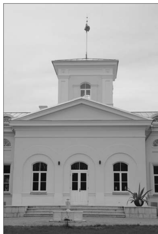
Na zdjęciu: Środkowy ryzalit elewacji ogrodowej
