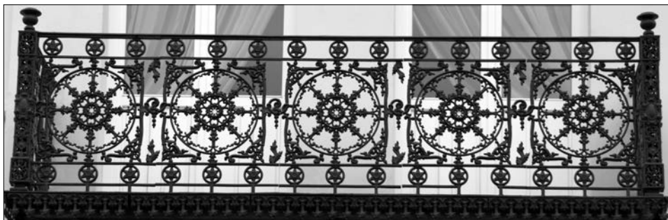
Na zdjęciu: Kuta w żelwie balustrada balkonowa
