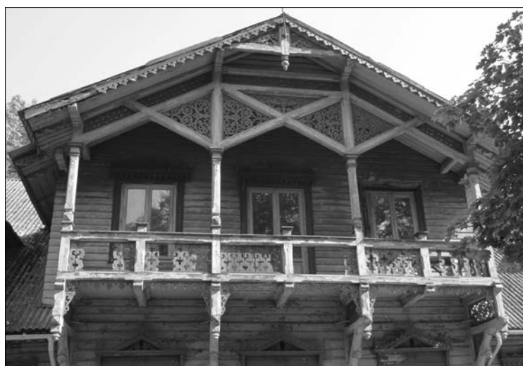
Na zdjęciu: Facjata w elewacji frontowej
